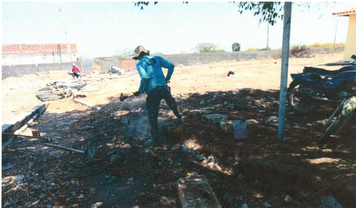
Foto 03 – RETIRADA DE MEIO-FIO DNER / ECONOMICO COM EMPILHAMENTO E SEM BOTA FORA
