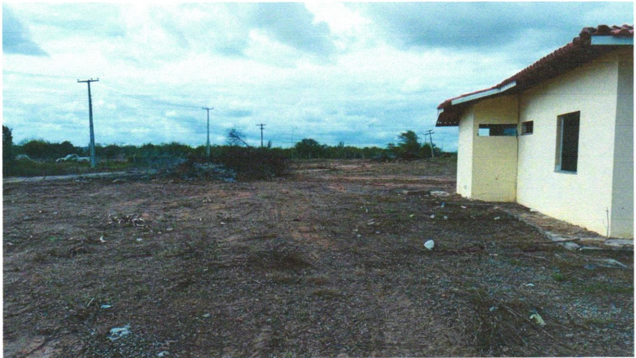
Foto 05 - LIMPEZA MANUAL DO TERRENO COM RASPAGEM SUPERFICIAL (CAPINAÇÃO)
