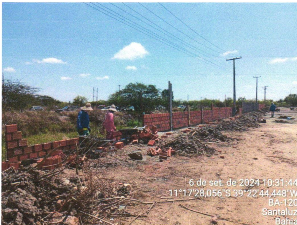
Foto 11 - ALVENARIA DE VEDAÇÃO DE BLOCOS CERÂMICOS FURADOS NA VERTICAL DE 9X19X39 CM (ESPESSURA 9 CM) E ARGAMASSA DE ASSENTAMENTO COM PREPARO EM BETONEIRA. AF_12/20212021
