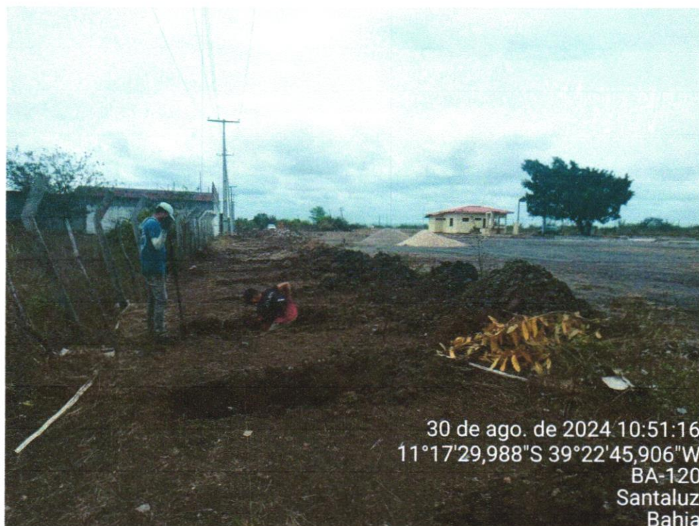
Foto 08 - ESCAVAÇÃO MANUAL DE VALA COM PROFUNDIDADE MENOR OU IGUAL A 1,30 M
