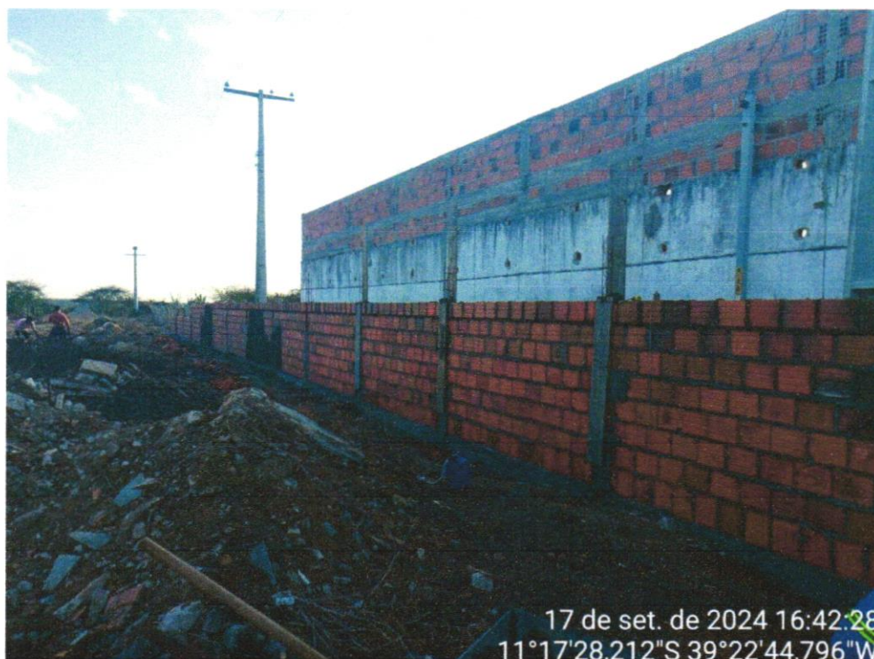
Foto 10 - ALVENARIA DE VEDAÇÃO DE BLOCOS CERÂMICOS FURADOS NA VERTICAL DE 9X19X39 CM (ESPESSURA 9 CM) E ARGAMASSA DE ASSENTAMENTO COM PREPARO EM BETONEIRA. AF_12/2021
