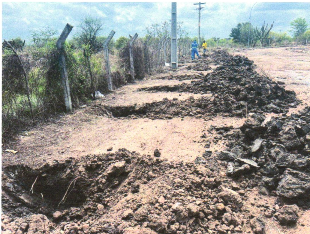
Foto 07 - ESCAVAÇÃO MANUAL DE VALA COM PROFUNDIDADE MENOR OU IGUAL A 1,30 M
