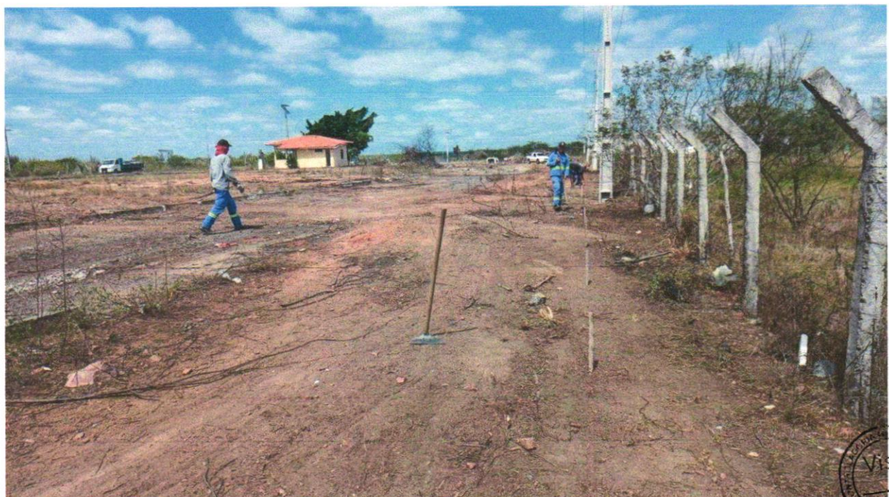
Foto 06 - LIMPEZA MANUAL DO TERRENO COM RASPAGEM SUPERFICIAL (CAPINAÇÃO)
