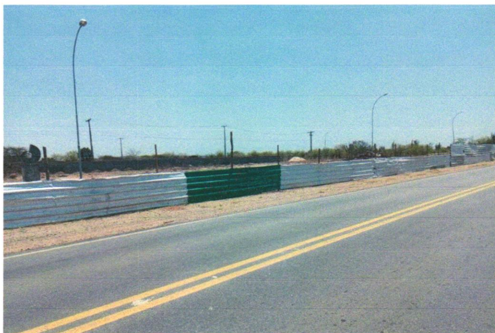
Foto 01 - TAPUME COM TELHA METÁLICA. AF_05/2018
