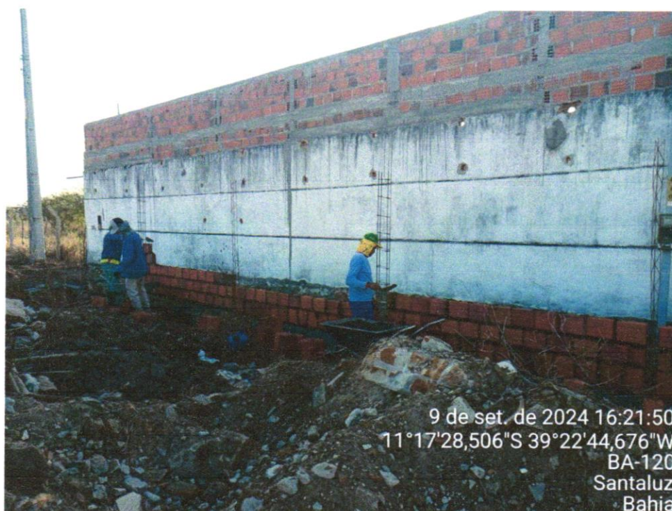
Foto 12 - ALVENARIA DE VEDAÇÃO DE BLOCOS CERÂMICOS FURADOS NA VERTICAL DE 9X19X39 CM (ESPESSURA 9 CM) E ARGAMASSA DE ASSENTAMENTO COM PREPARO EM BETONEIRA. AF_12/2021
