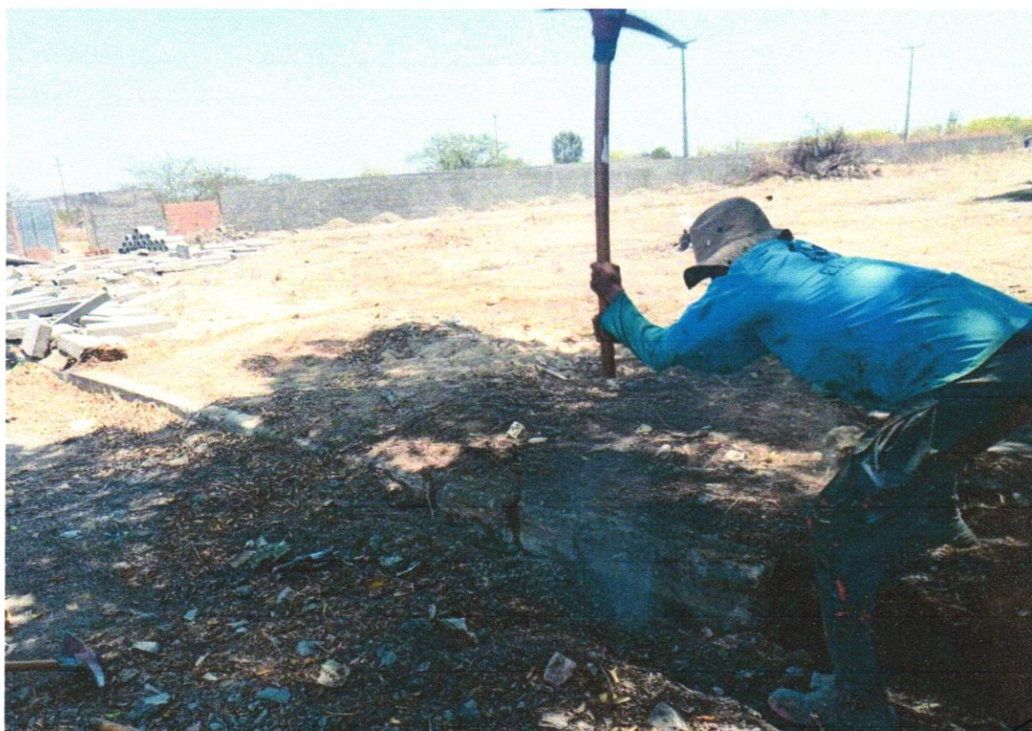
Foto 04- RETIRADA DE MEIO-FIO DNER / ECONOMICO COM EMPILHAMENTO E SEM BOTA FORA
